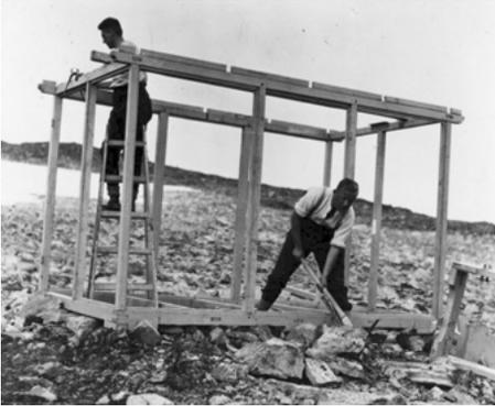
Im August konnte man in Grönland hemsärmerlig arbeiten. Hier wurde aus in Dänemark vorgefertigten Teilen ein Winterlager aufgebaut.
